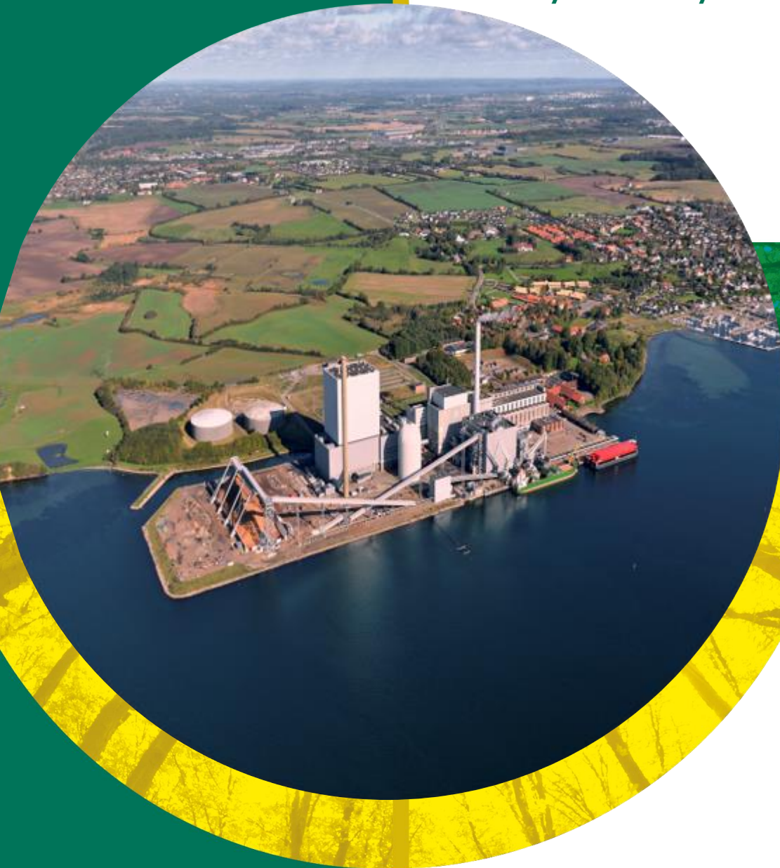
Skærbæk CHP plant, Denmark. Photo: Ørsted
